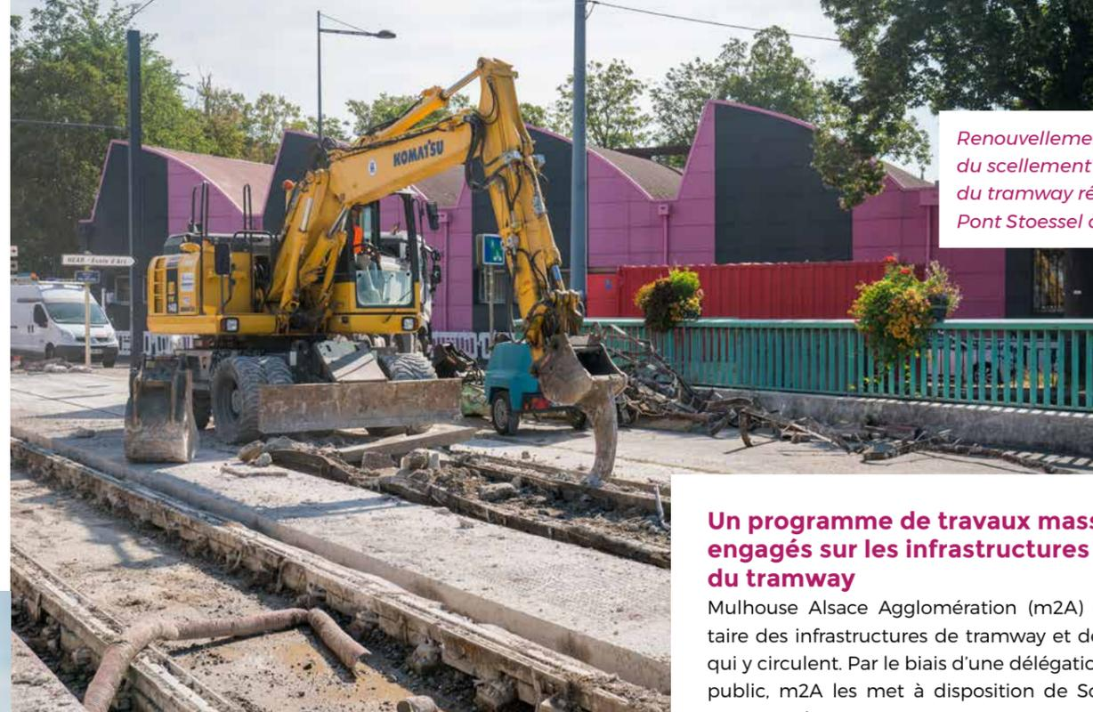
Renouvellement du scellement des rails du tramway réalisé sur le Pont Stoessel à Mulhouse
